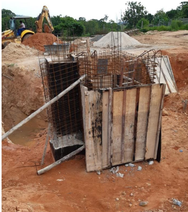
Figura 84 – Construção da Estação Elevatória de Esgoto (EEE).
