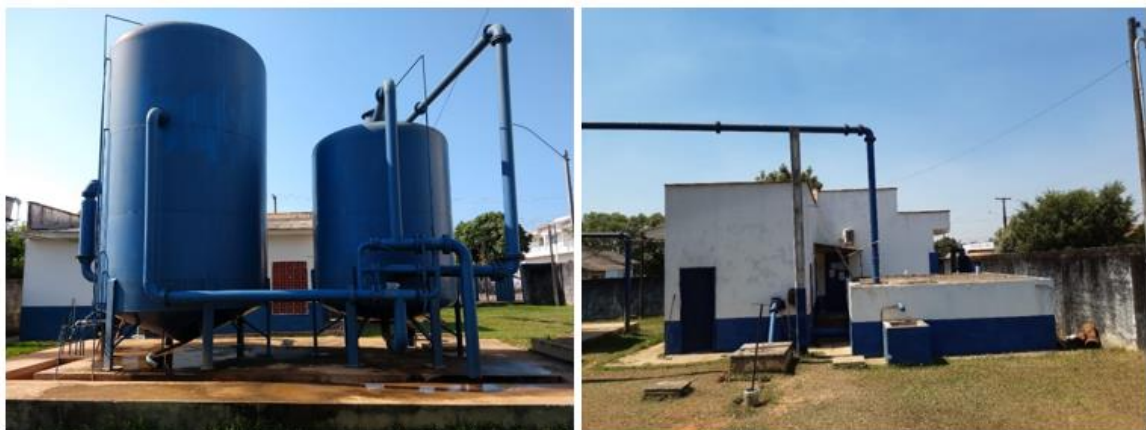
Figura 51 – Floco decantador e filtro de fluxo misto e tanque de contato- desinfecção por cloro.
