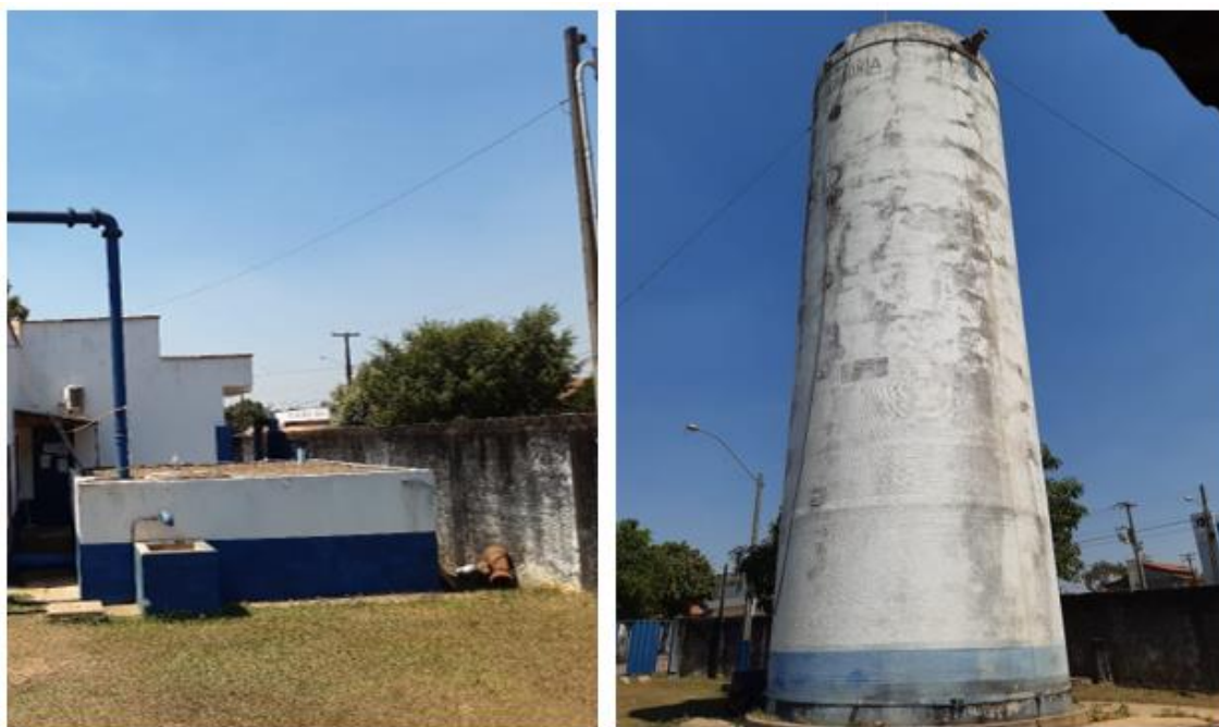
Figura 66 - Reservatório apoiado e reservatório elevado.
