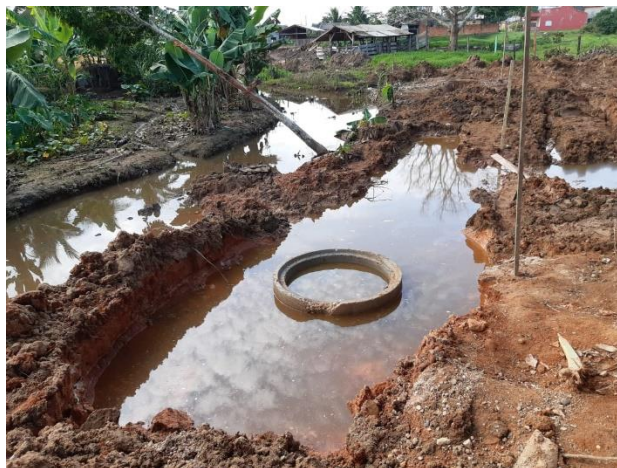
Figura 83 — Execução de interceptor e seu respectivo poço de visita.
