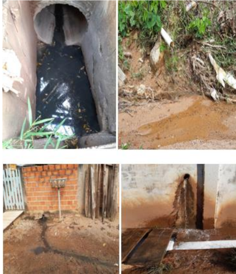
Figura 99 – Lançamento de esgoto na área urbana.
