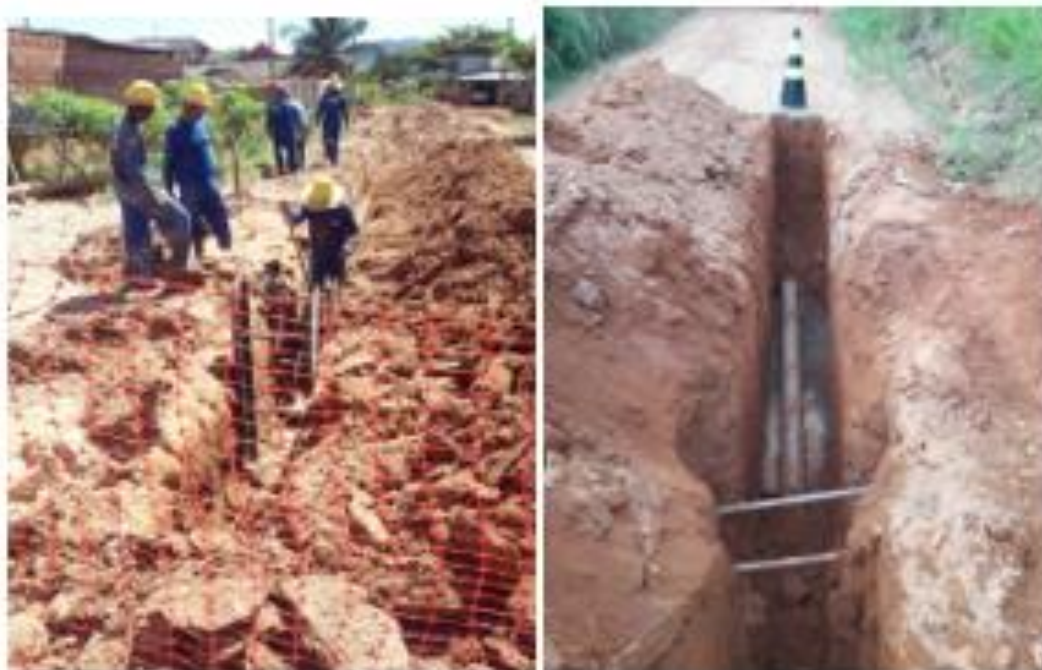
Figura 82 — Construção da rede coletora e poço de visita.
