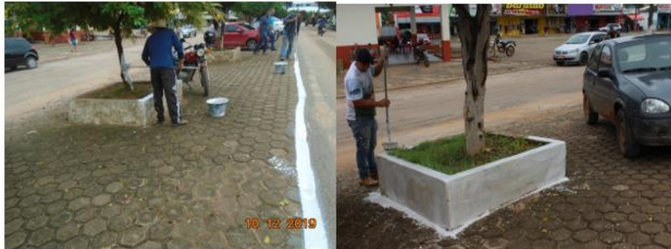
Figura 135 - Pintura de meio-fio.
