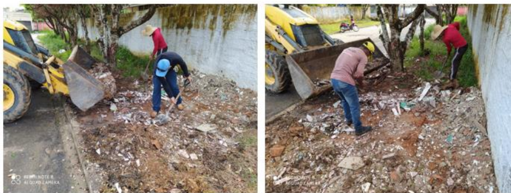
Figura 143 – Execução do serviço de limpeza de RCC.
