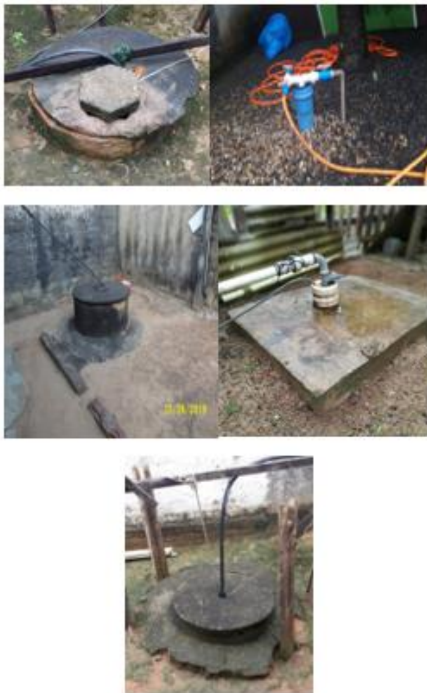
Figura 73 – Poços localizados na área urbana.
