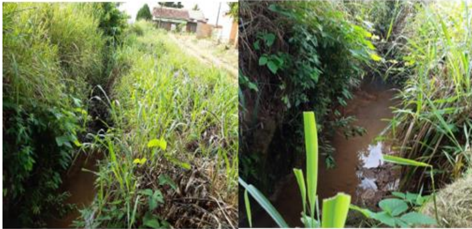
Figura 111 – Vala localizada na sede.
