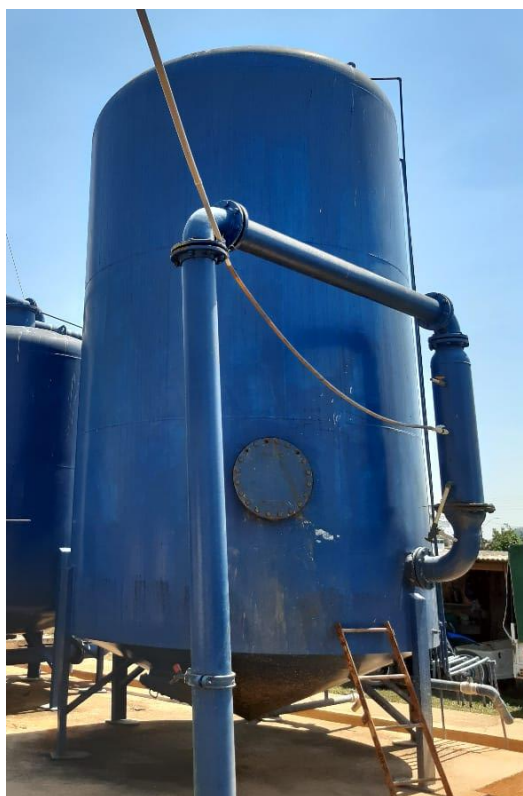
Figura 53 – Floculador Decantador
