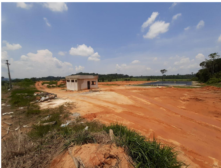
Figura 86 – Área da Estação de Tratamento de esgoto.
