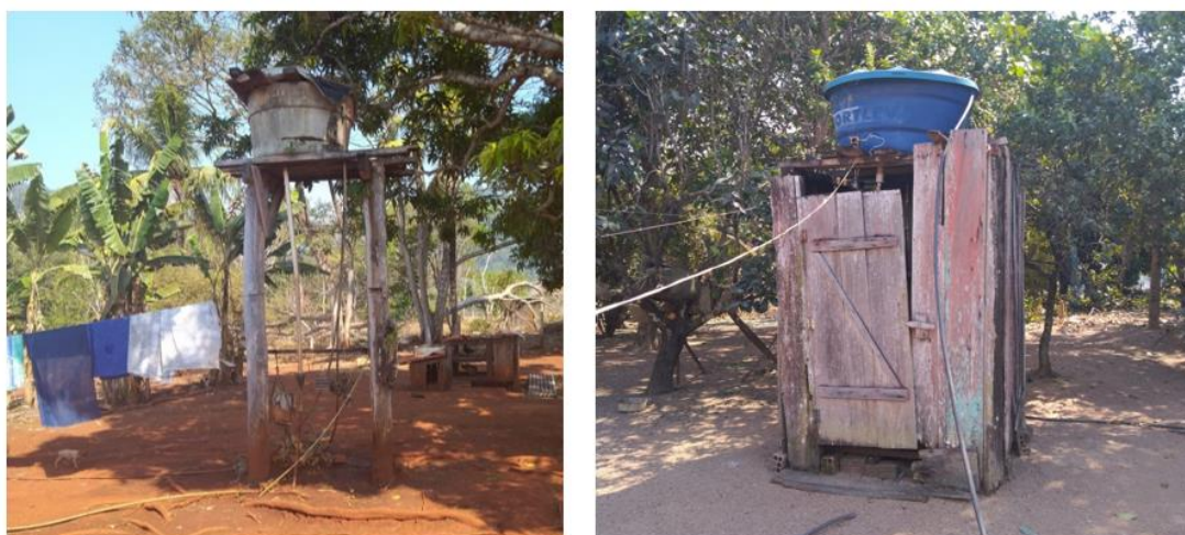
Figura 29 - Caixas d'água na área rural do município
