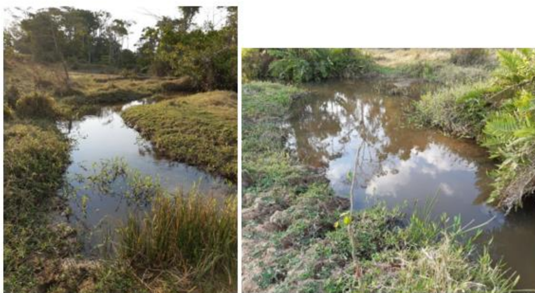
Figura 91 – Vista do corpo receptor de efluente do SES de Ministro Andreazza – RO.
