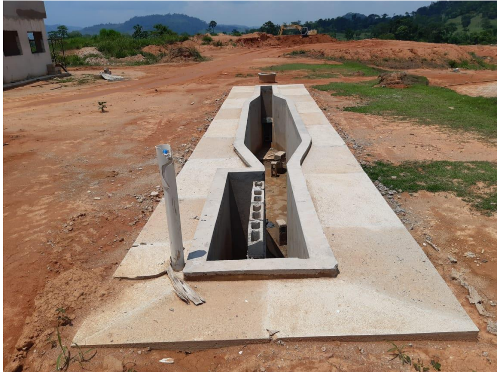
Figura 87 – Tratamento Preliminar e primário.
