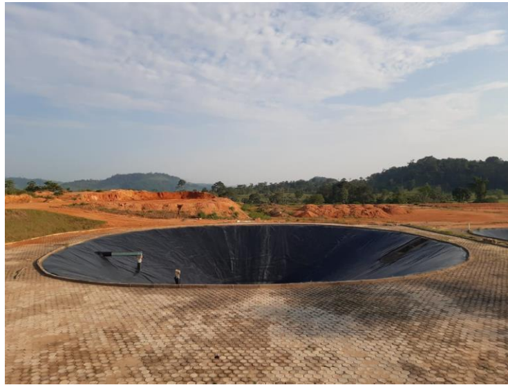
Figura 88 – Lagoa Anaeróbia.
