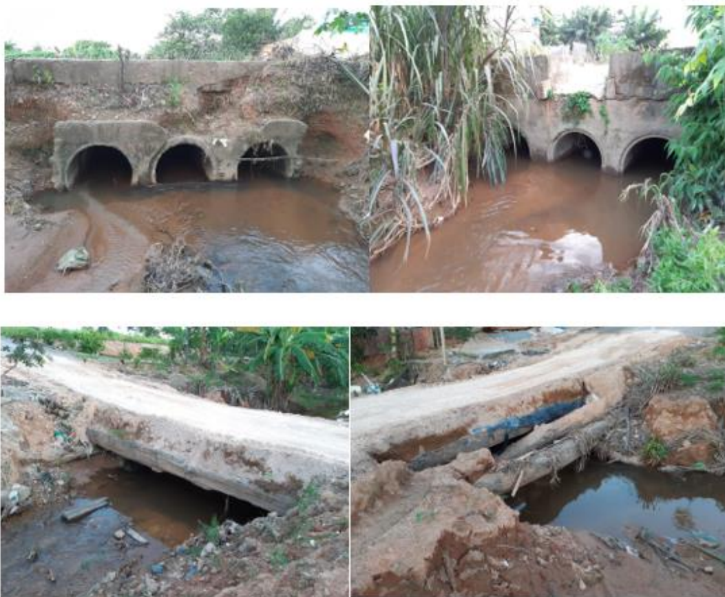
Figura 110 – Galeria e ponte localizados na sede.
