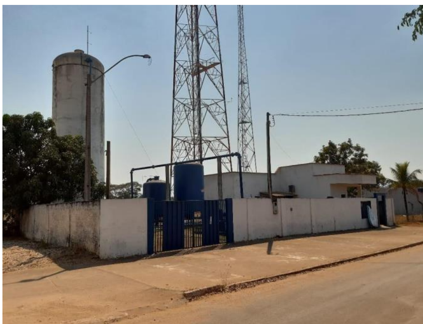
Figura 49 – Estação de Tratamento de Água (ETA) do município de Ministro Andreazza.
