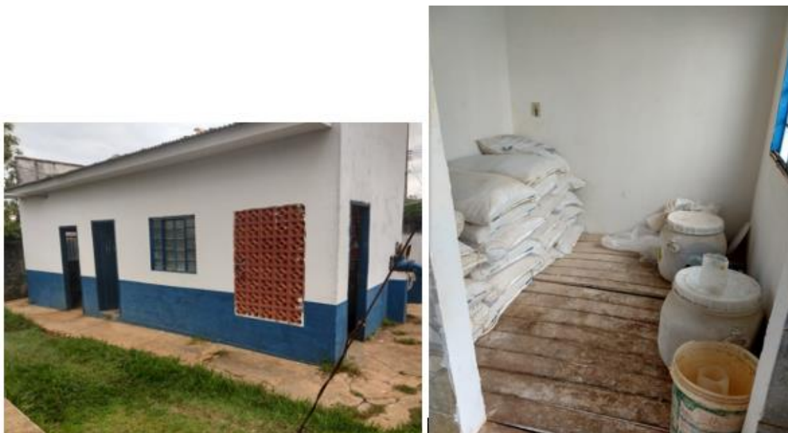
Figura 58 - Vista da casa de química e produtos químicos - sulfato de alumínio e hipoclorito de cálcio
