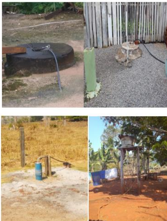
Figura 70 — Captação de água e reservação na área rural do Município de Ministro Andreazza.
