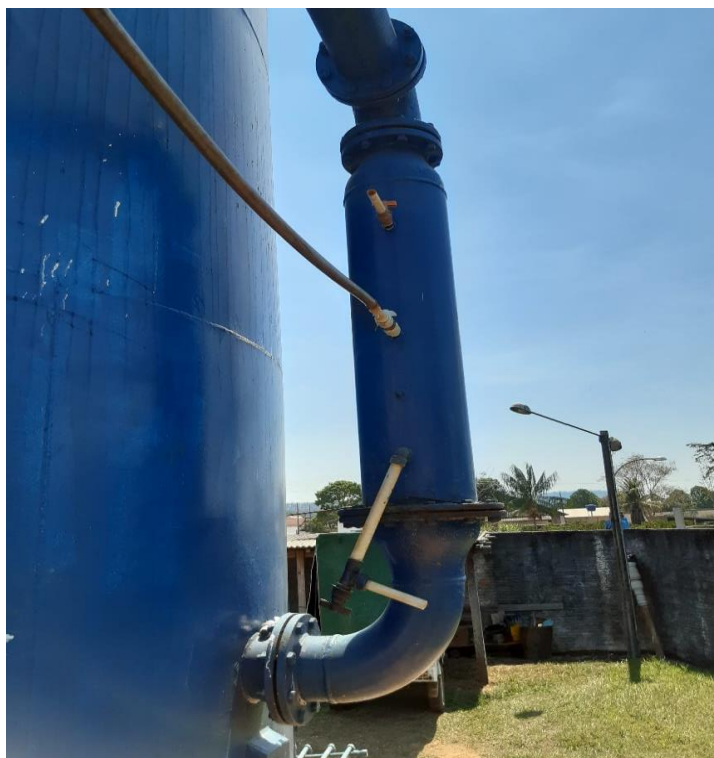
Figura 52 — Dispersor Hidráulico
