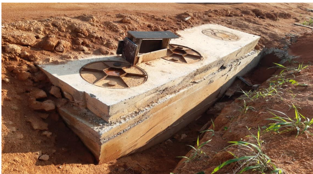
Figura 85 – Construção da caixa de transição.
